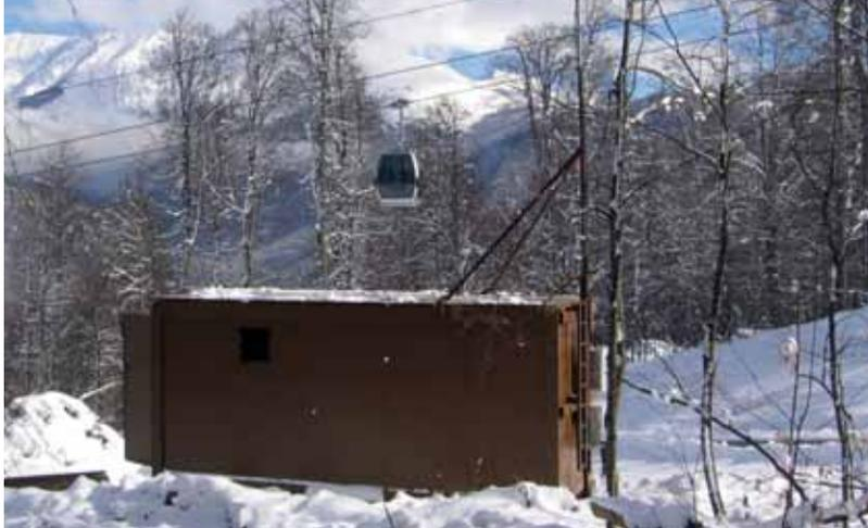
Container mit Wärmedämmung schützen die Basisstation vor extremen Umweltbedingungen.
